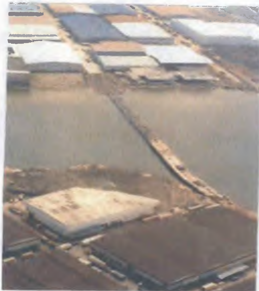
Vista del Puente Silvio Salazar que une el Casco Viejo de la Zona Libre de Colón y la Zona de Carga en France - Field después del relleno realizado por COFRISA.
