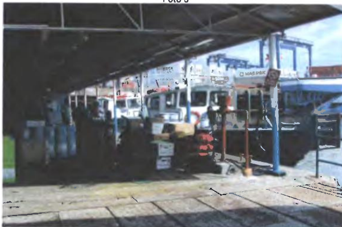
Muelle que Utiliza Transibérica para Servicio de Lanchas
