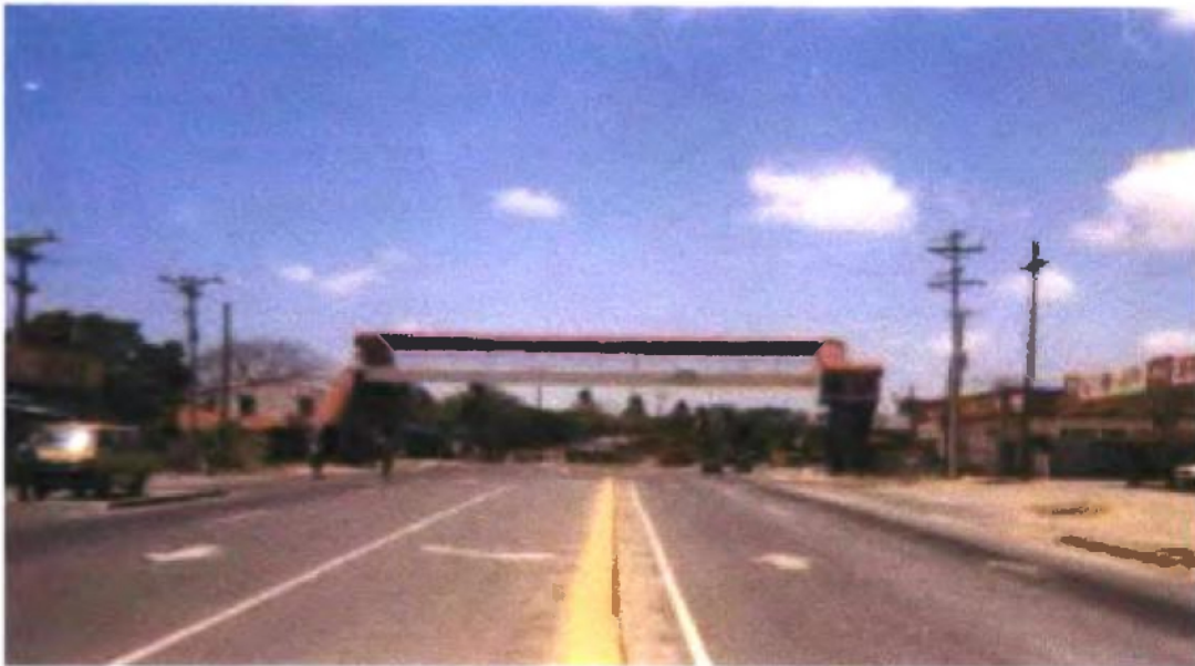
Figura N°22 PUENTE PEATONAL EN LA VÍA PANAMERICANA EN ANTÓN
