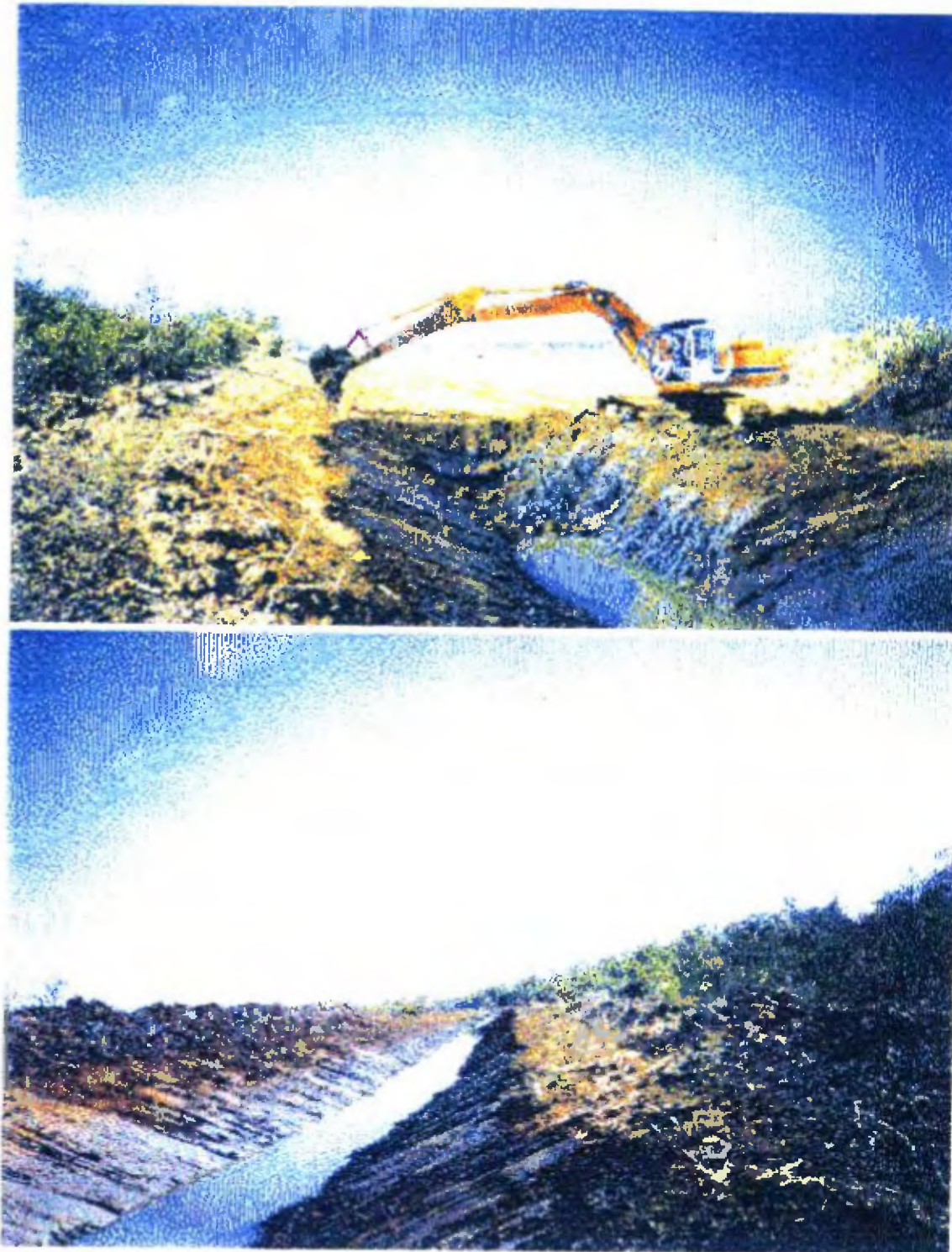
Fig. N° 13 Construcción del canal de drenaje, realizada por la Pala CARTEPILLAR
