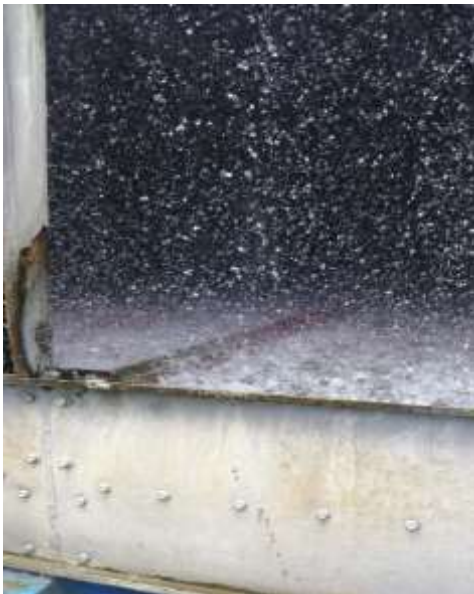
Biofilm en las torres de enfriamiento promueve la protección y crecimiento de Legionella pneumophila
