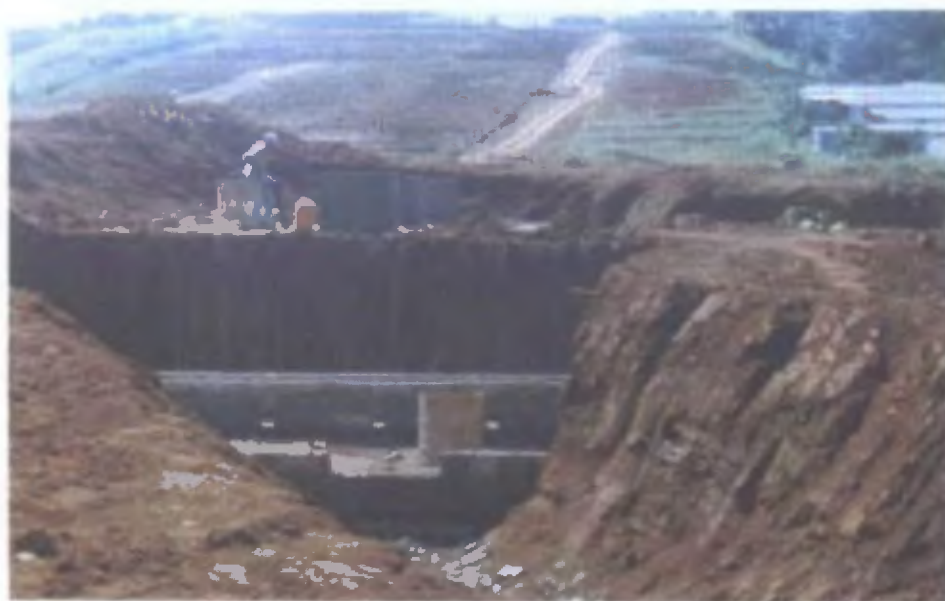
Movimiento de tierra y construcción de tanques sépticos, a orillas del Río Aguacate.
