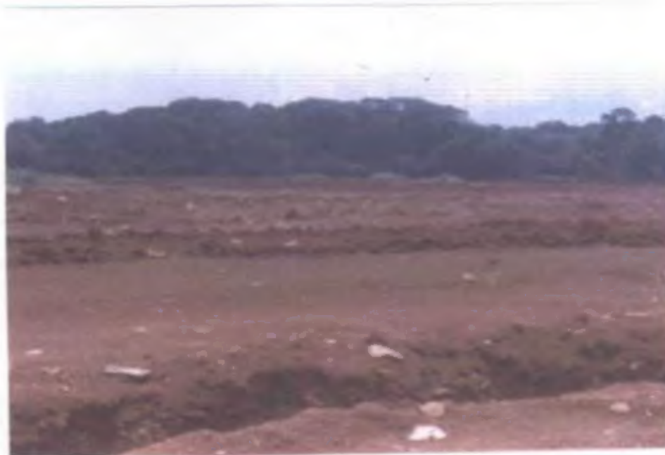
Movimiento de tierra para la construcción de una urbanización; al fondo bosques de galería del Río Aguacate.
