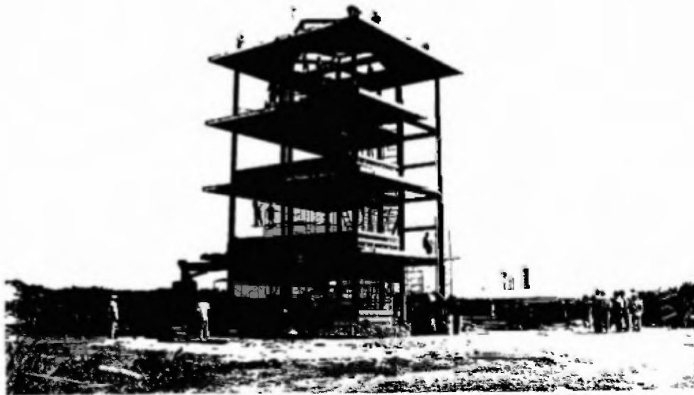
CONSTRUCCION DE LA TORRE DE CONTROL DEL AEROPUERTO DE ALBROOK FIELD
