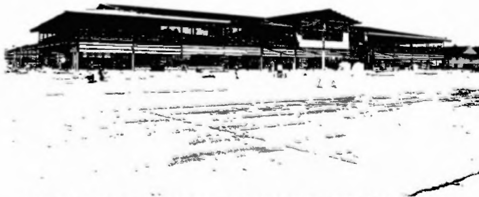
VISTA DE LA CONSTRUCCION DEL TERMINAL DE DE PASAJEROS DESDE LA PISTA PRINCIPAL DEL AEROPUERTO DE ALBROOK FIELD
