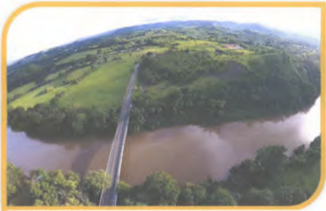
FIG. 9 VISTA DEL RÍO SAN PABLO, CORREGIMIENTO SONÁ CABECERA
