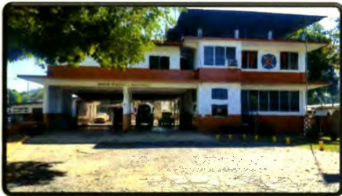
FIG. 40 ESTACIÓN DE BOMBEROS, CORREGIMIENTO SONÁ CABECERA.
