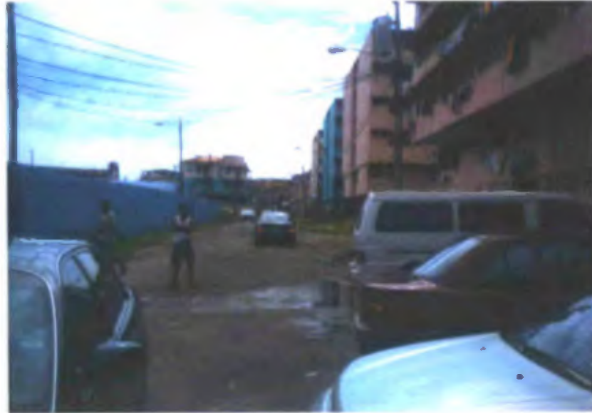
MULTIFAMILIARES QUE SE ENCUENTRAN LATERAL AL CENTRO DE SALUD. EN EL EDIFICIO VERDE VIVE UNA DE LAS BANDAS JUVENILES DE ESTE SECTOR.
