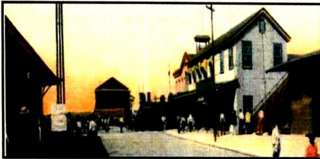
Foto. 17 Vista panorámica de la Estación del Ferrocarril y la entrada al Muelle 3, escenarios de la gesta emancipadora de 1903.
