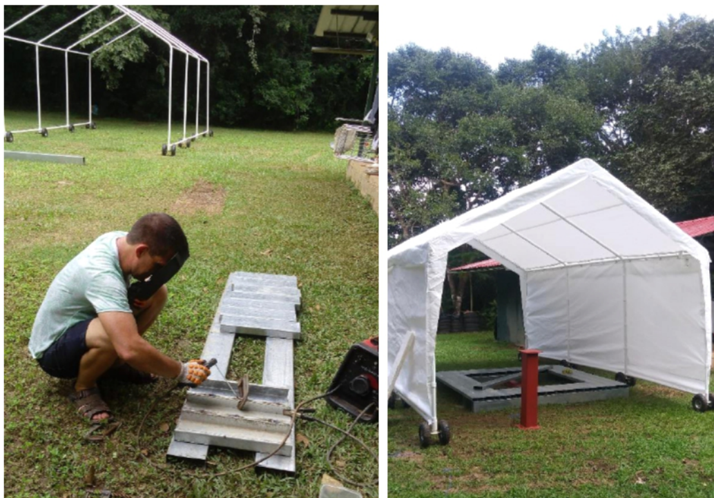
Figura 6. Construcción del piso que soporta el domo. También se adaptaron ruedas a una tolda que protege el domo de las lluvias fuertes y es fácil de remover. En rojo, la base metálica antes de ser fijada al suelo y que ha de sostener a la montura robótica.
