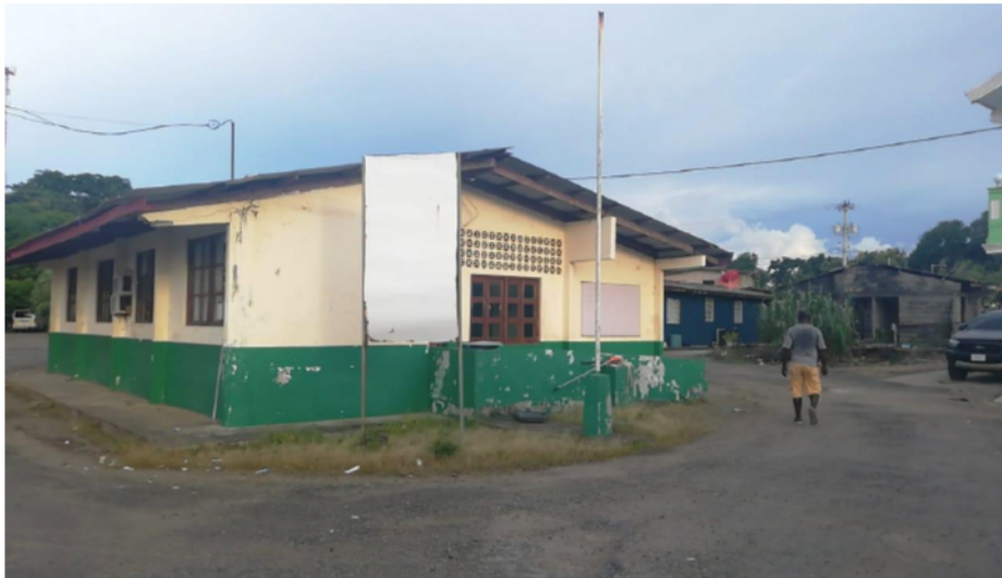
Figura 18 Instalaciones del Centro de Salud
