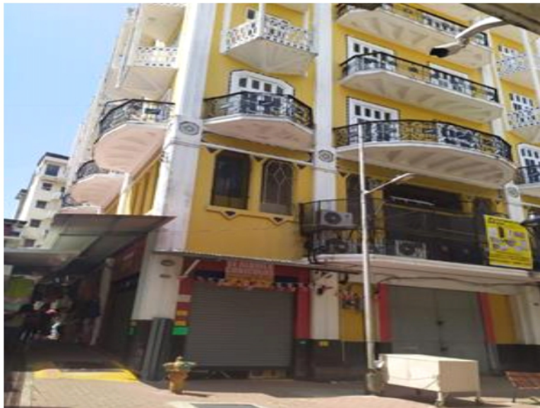
Figura 23 Edificio La Pollera.
