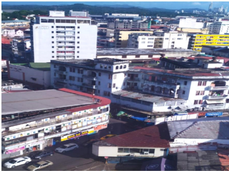
Figura 38 Vista Panorámica del corregimiento Santa Ana.
