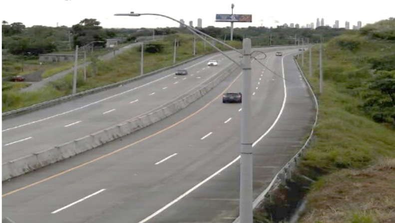
Figura SEQ Figura \* ARABIC 15: Corredor Norte a su paso por la comunidad de San José.
