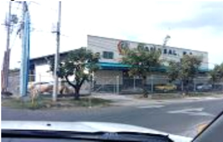
Figura 16: Instalación de Panasal
