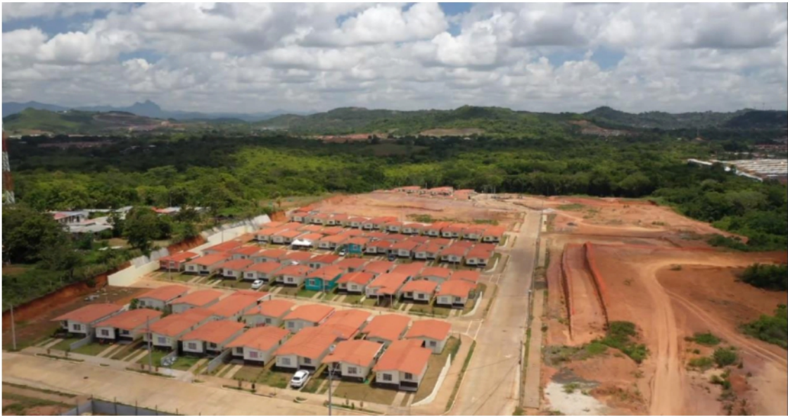
Figura 21 Vista panorámica de permite comprobar los cambios de usos de la tierra en áreas de contingencia de la comunidad de La Mitra.
