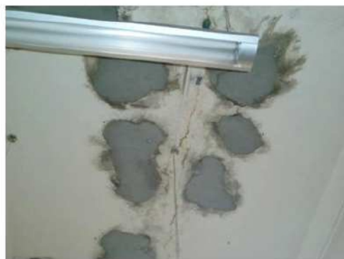
Imagen 51: Visualizamos del lado izquierdo ejemplo de humedades, mientras a la derecha vemos lo que fueron desprendimientos y luego fueron malamente resanados. Fuente: Foto de R. Cerón-C.
