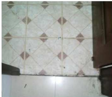
Imagen 49: Detectamos pavimentos cerámicos, de pasta y mármoles. Fuente: Foto de R. Cerón-C.
