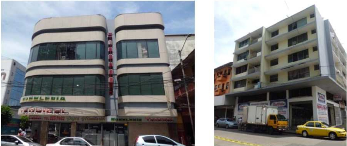
Imagen 34: A la izquierda la Mueblería Tropical. Derecha edificio de apartamentos de la década de los 70's. Fuente: Foto de R. Cerón-C.
