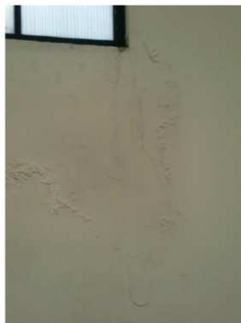
Imagen 48: Las Filtraciones producen desprendimientos y abultamiento de pintura Fuente: Foto de R. Cerón-C.
