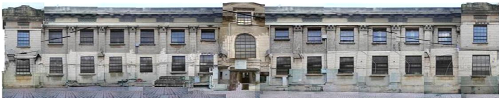
Vista de la fachada posterior
