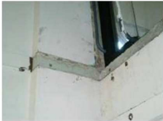
Imagen 47: Elementos desinstalados sin restauración posterior de acabado o pintura. Fuente: Foto de R. Cerón-C.
