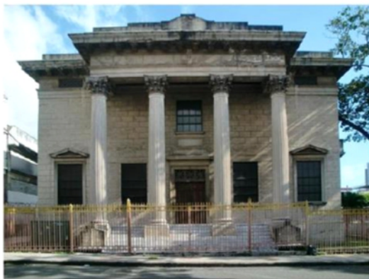
Vista de la fachada lateral izquierda
