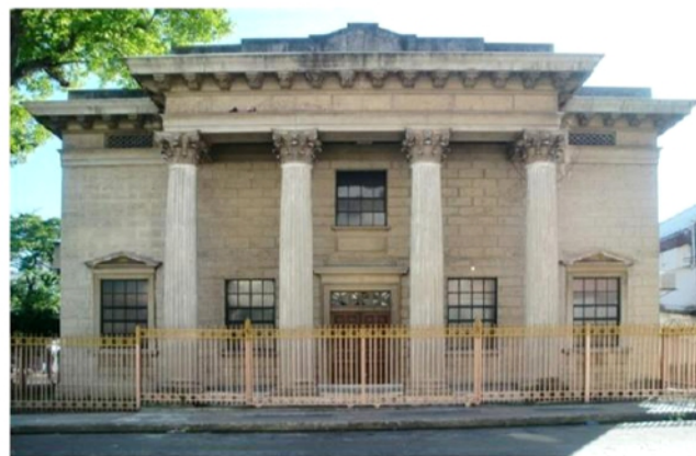
Vista de la fachada lateral derecha
