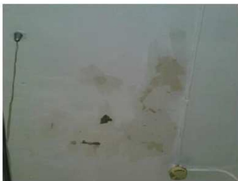
Imagen 51: Visualizamos del lado izquierdo ejemplo de humedades, mientras a la derecha vemos lo que fueron desprendimientos y luego fueron malamente resanados. Fuente: Foto de R. Cerón-C.
