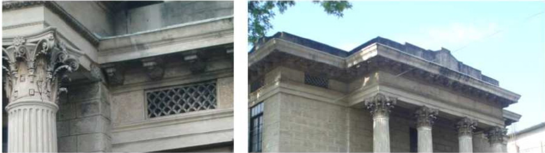
Imagen 15: Platabanda perimetral corrida sostenida por canecillos (Izq.) y pegada a las paredes (Der.) en fachadas laterales. Fuente: Foto de R. Cerón-C.
