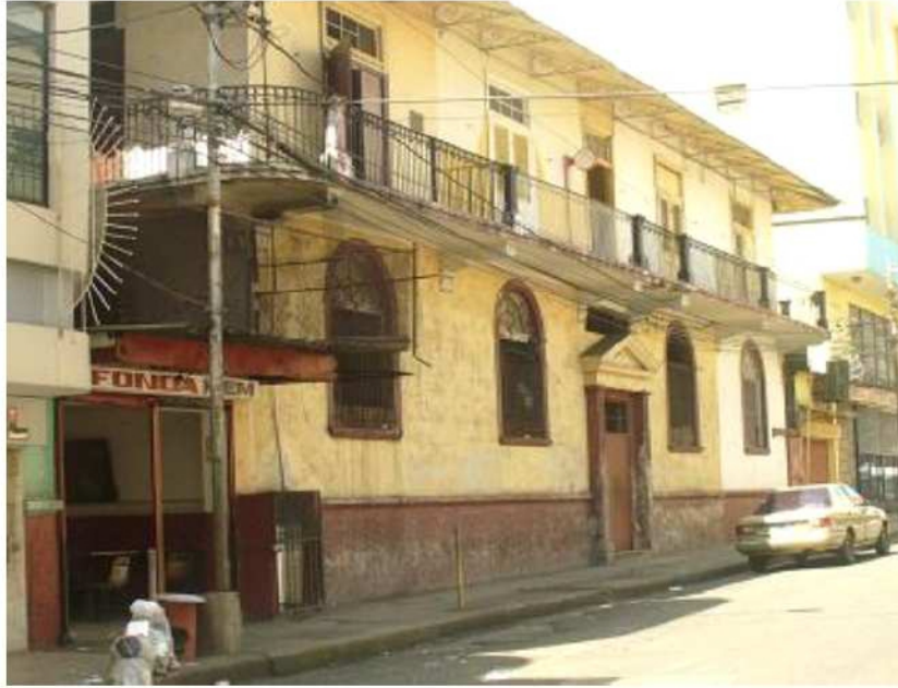
Imagen 39: Casa 3267 ubicada en calle 31 lateral al Archivo Nacional principal Fuente: Foto de R. Cerón-C.
