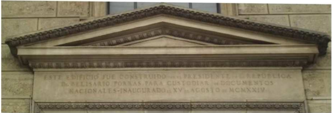
Imagen 23: Dintel con la descripción de su construcción, rematado con cornisa adornado con detalles de "punta de lanza" y frontón proyectado adornado con listello floral. Fuente: Foto de R. Cerón-C.
