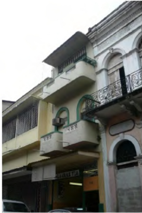
Inmueble 50-12 Categoría 3 Zona Tres: Ave. 7ª Central. Entre calle 11 y 12 Este
