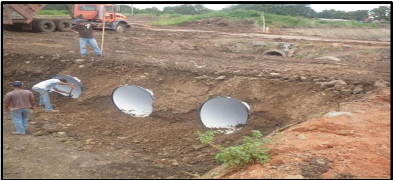
Figura 42 cambio de tuberías
