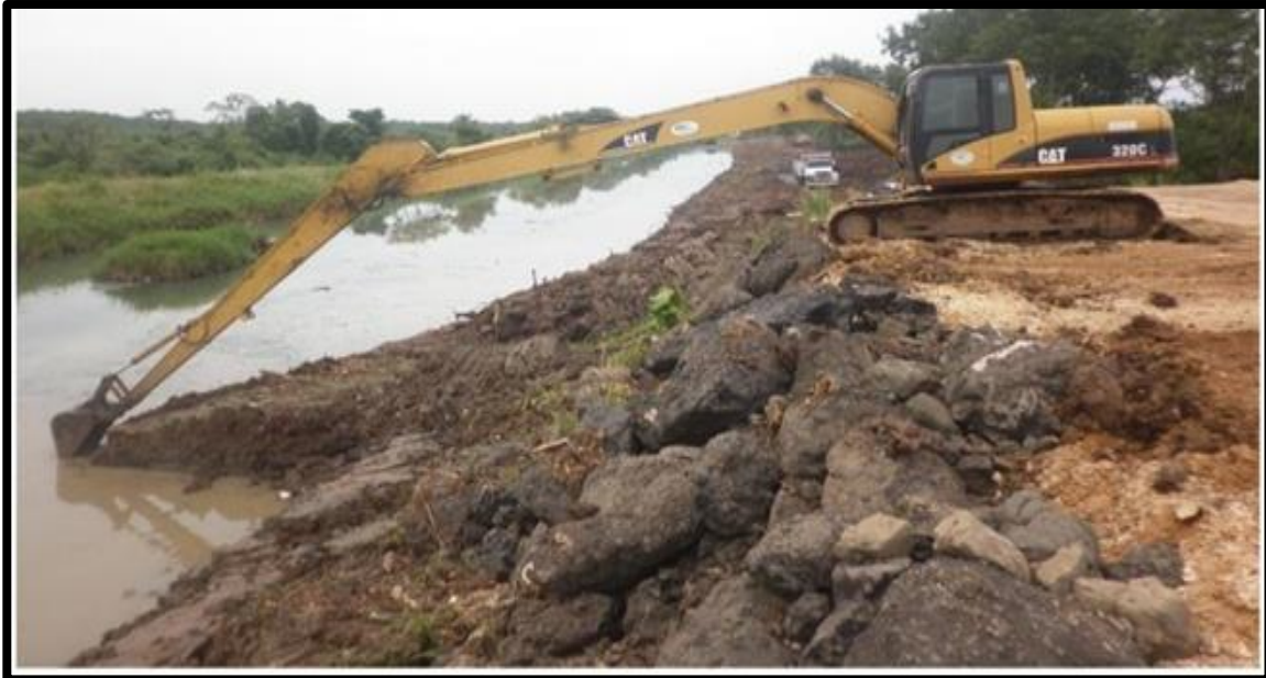
Figura 25. Trabajos en la cuenca baja del río Juan Díaz
