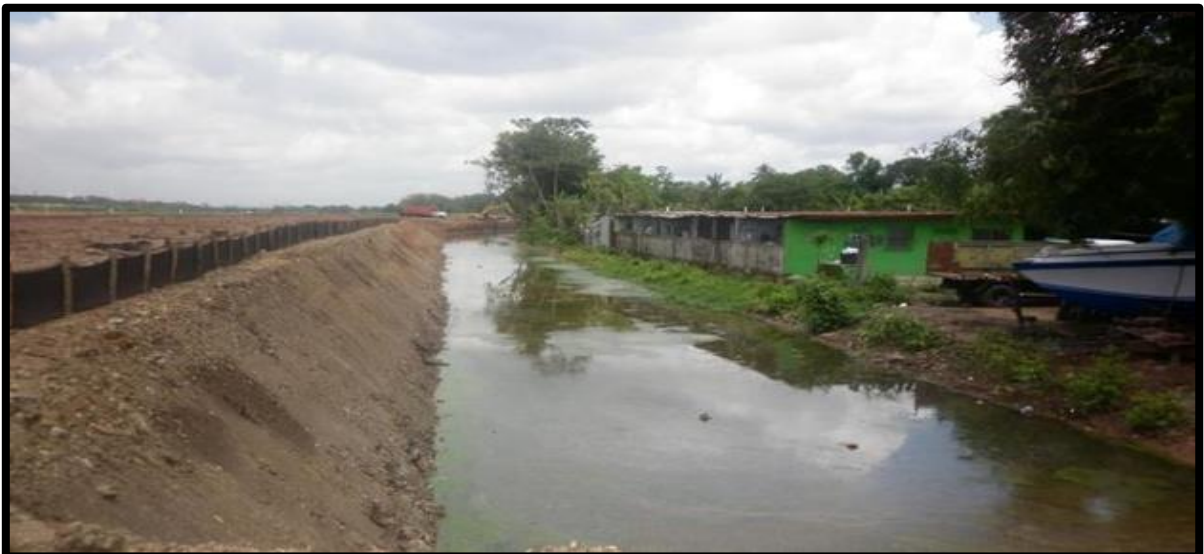
Figura 40. Después de la ampliación del canal longitudinal Metro Park
