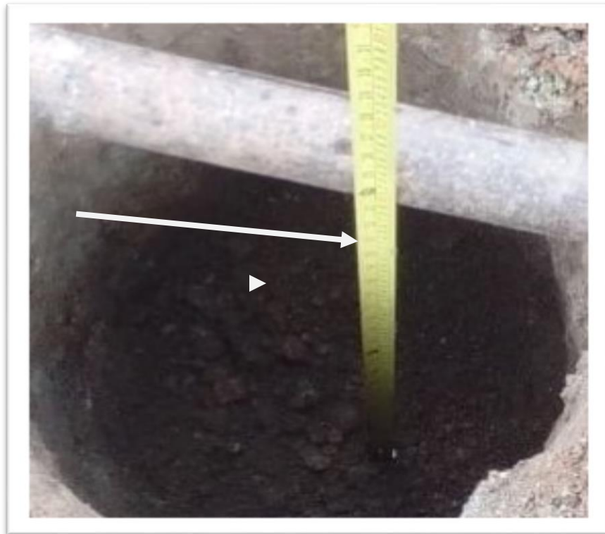
Fig. No 11. En esta imagen apreciamos el momento en el que realizamos el hueco con las dimensiones recomendadas por el IGNTG.
