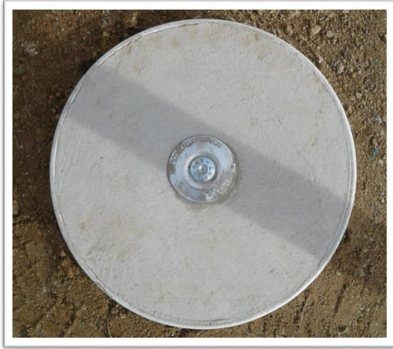
Fig. No 12. En esta imagen podemos apreciar los tipos de monumentos que construimos, tomando en cuenta las normas exigidas por el IGNTG. 30 cm de ancho x 60 cm de profundidad.
