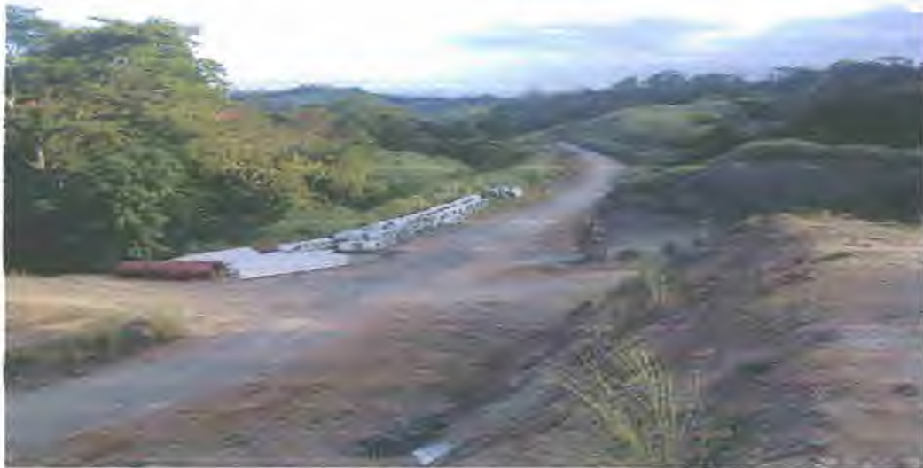
Figura N° 25 Camino conocido como la calle del I.D.A.A.N. en el tramo María Henríquez Gonzalillo
