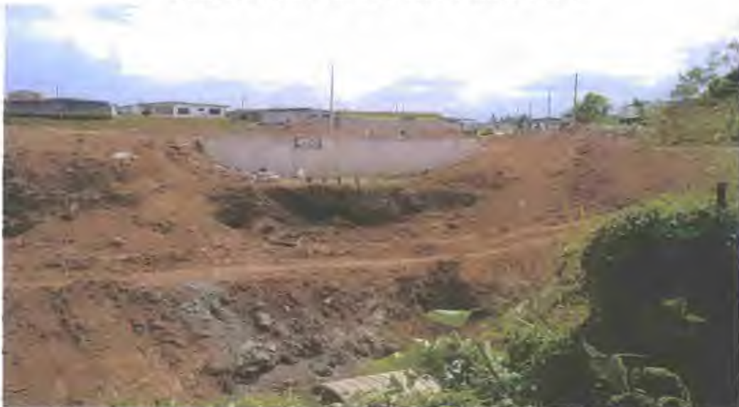
Figura N° 50 Tanque séptico en la Barriada Montserrat
