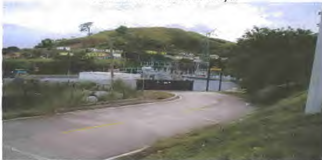
Figura N° 18 Sub. Estación eléctrica de Tinajita
