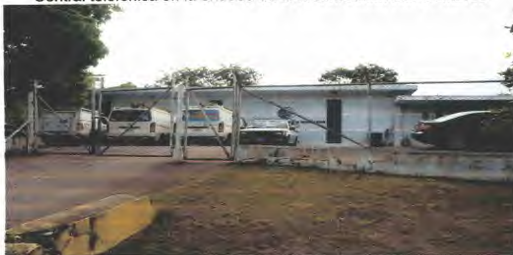
Figura N° 19 Central telefónica en la entrada de la urbanización Las Cumbres
