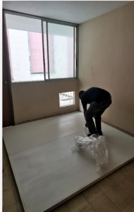
Imagen 66. Instalación de Piso de madera
