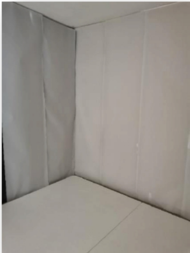
Imagen 70. Instalación de Papel
