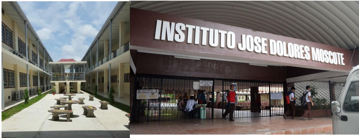
Figura 2. INSTALACIONES FÍSICAS DE LA INSTITUCIÓN EDUCATIVA
