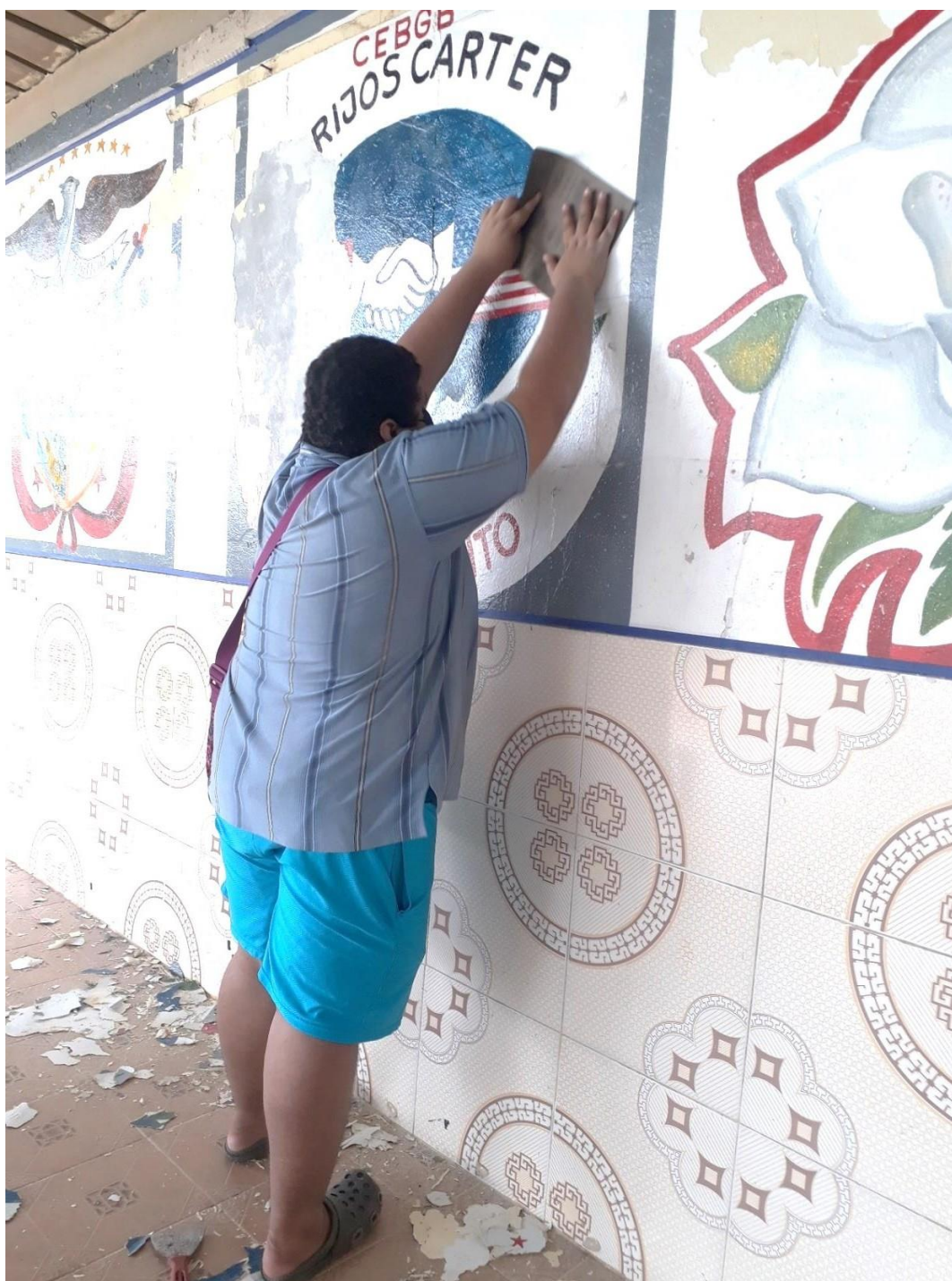
Lijado de la pared para eliminar sedimentos e incrustaciones de materiales pegados a la pared
