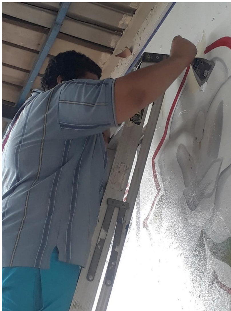
Raspado de incrustaciones de concreto y otros materiales pegados a la pared
