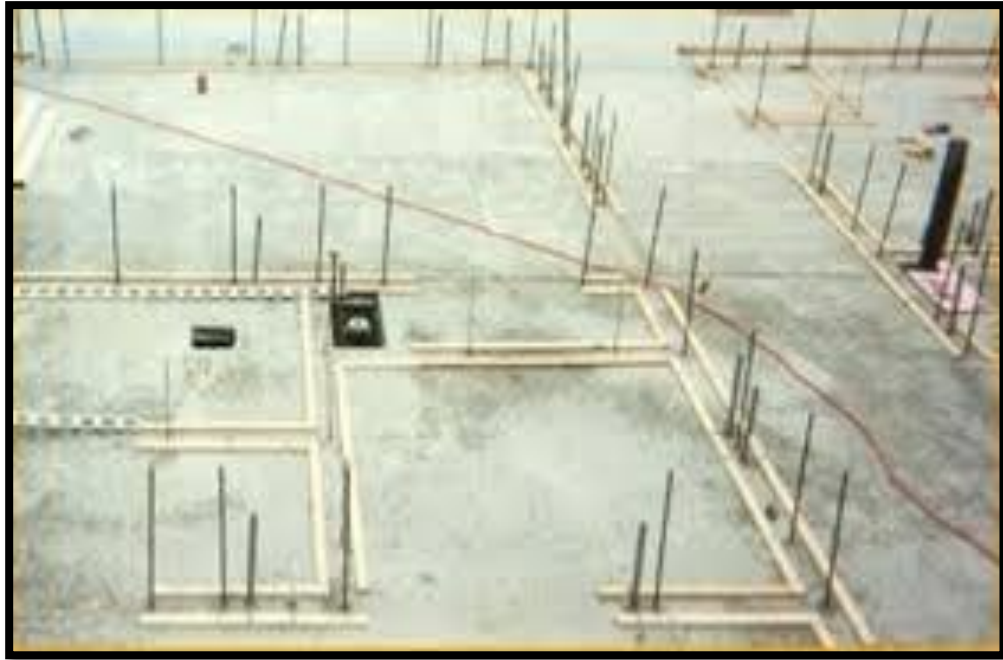
Ilustración 15. Replanteo de muros e instalación de refuerzo
