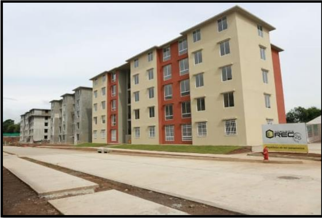
Ilustración 68. Detalles de finalización de obra
