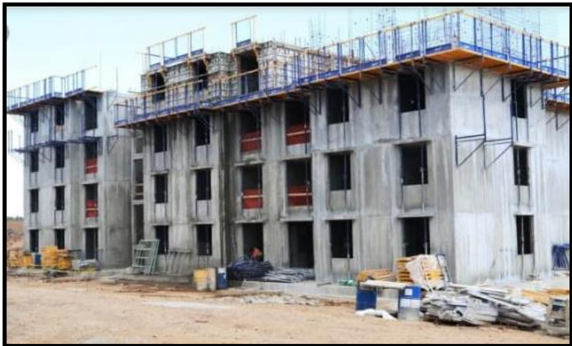
Ilustración 66. Imágenes del proceso de construcción
