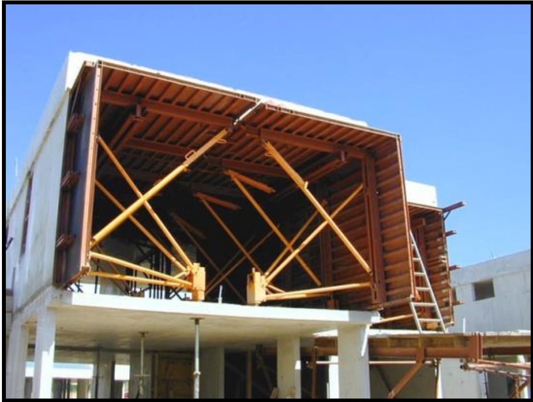
Ilustración 56. Sistema túnel para la construcción de estructuras de concreto
