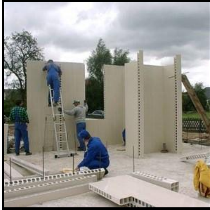
Ilustración 10. Instalación de muros
