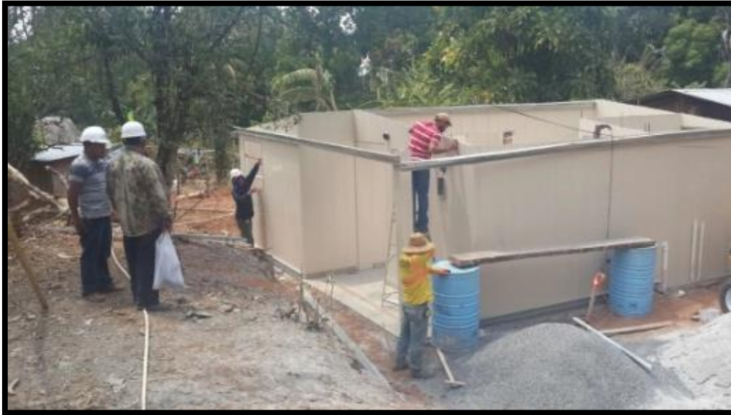
Ilustración 28. Etapas de construcción
