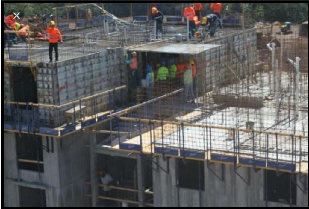
Ilustración 67. Etapa de construcción del proyecto
