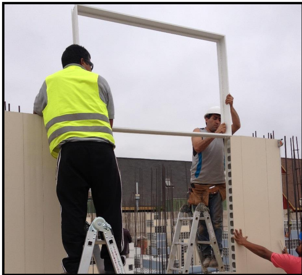
Ilustración 23. Instalación de ventanas
