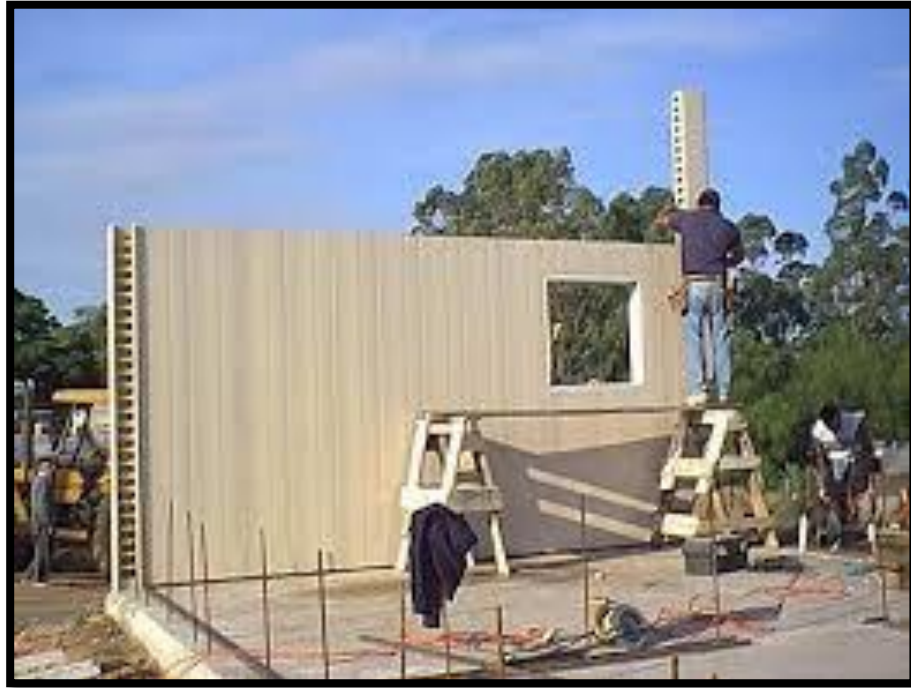
Ilustración 16.Instalación de muros
