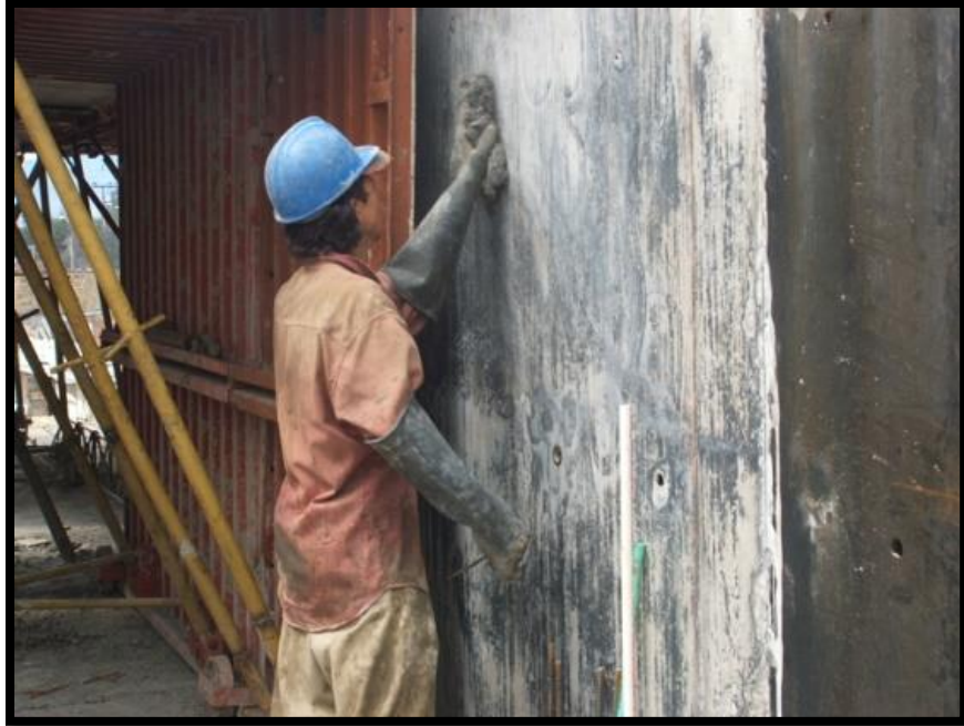
Ilustración 58.Limpieza de muros de concreto una vez retirada la formaleta
