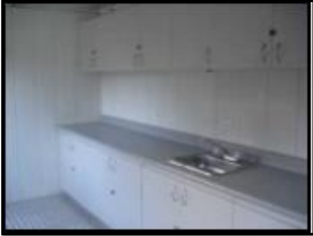
Ilustración 22. Acabados de cocina
