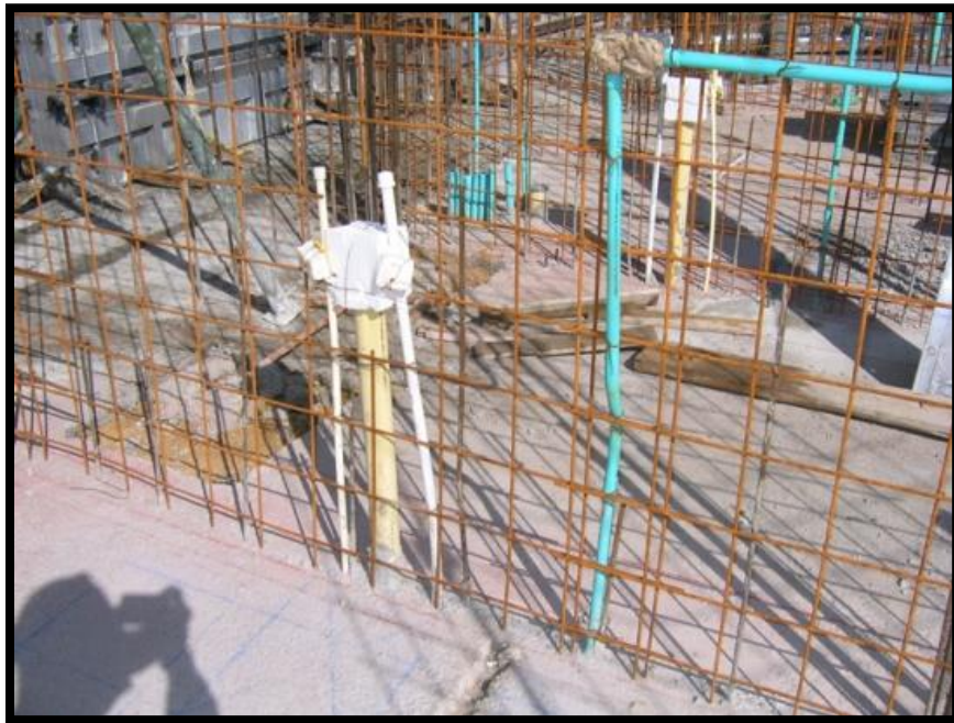
Ilustración 57. Colocación de acero de refuerzo e instalaciones domiciliarias en sistemas industrializados de construcción
