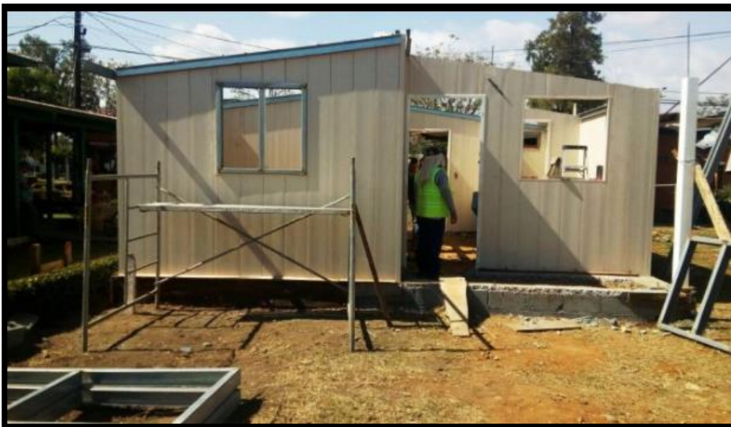
Ilustración 29. Etapa de construcción
