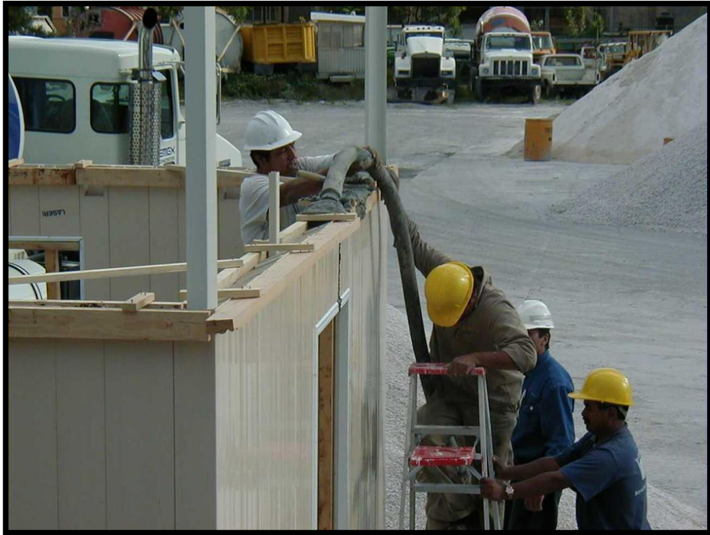
Ilustración 17. Relleno de muros
