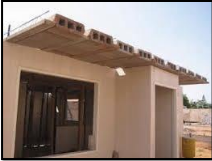
Ilustración 20. Instalación de losa entrepiso placa
