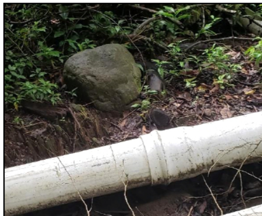
Ejemplo de tubería de PVC con garganta, nótese la unión entre tubos.
