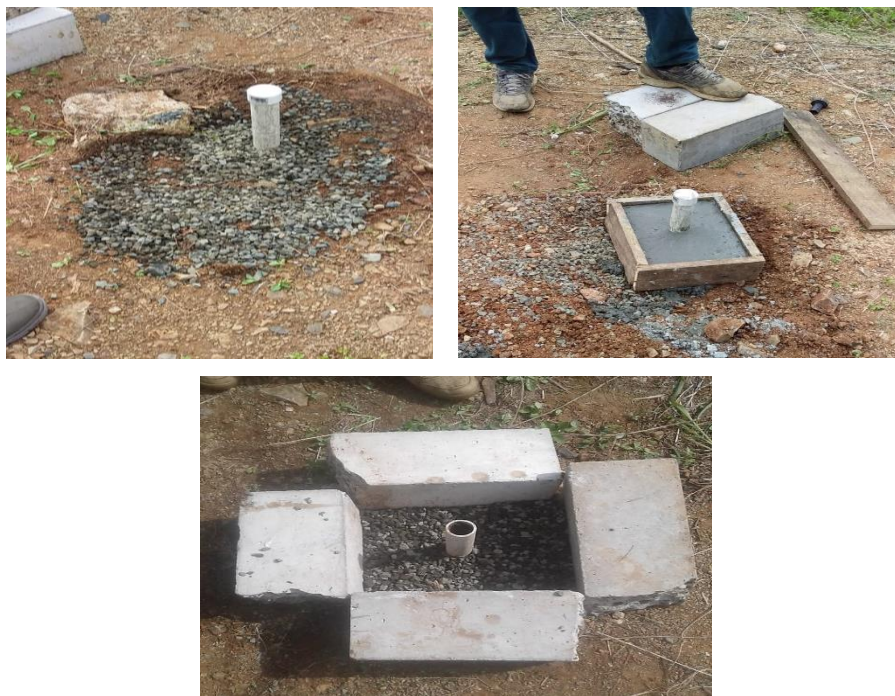
Figura N°13: Instalación de los pozos
