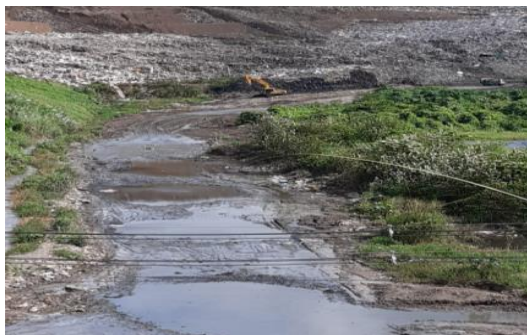
Figura 12: Muestra del manejo no controlado de aguas pluviales. Fuente: AAUD,2019.
