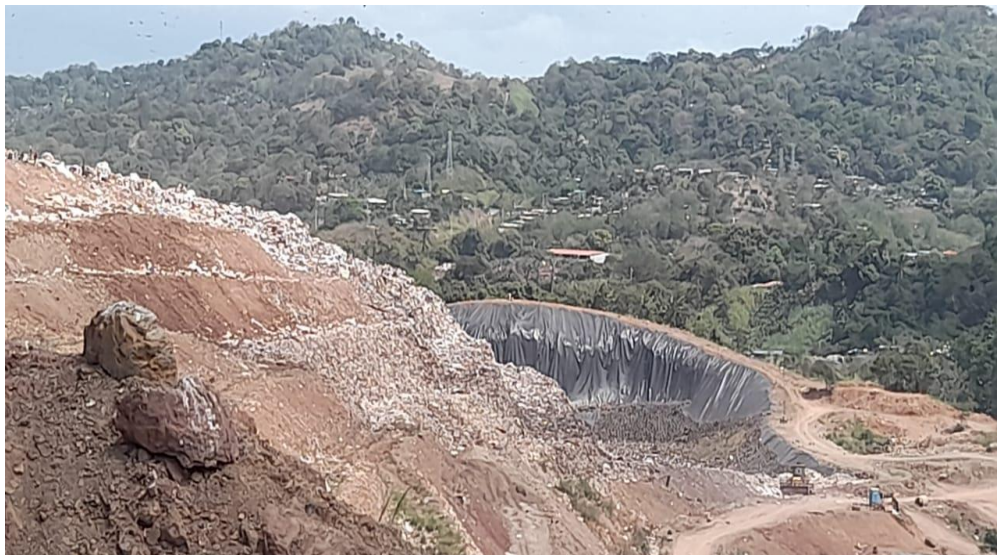
Anexo 2: Perspectiva desde un nivel más alto del estado del vertedero.
