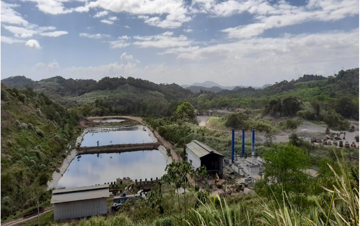
Anexo 3: Vista panorámica de las tinas de oxidación donde se realiza el tratamiento de los lixiviados.
