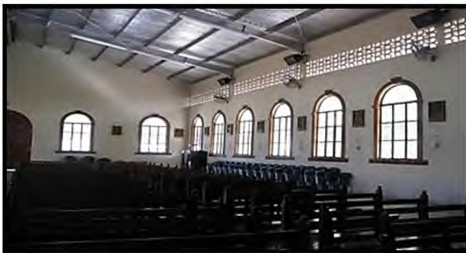
Fotografía No. 4 Vista interior de los ventanales de la iglesia. Fuente: Gae L. Cohen
