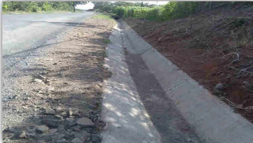
Imagen 3.5 Vista de la cuneta terminada en parte de la carretera
