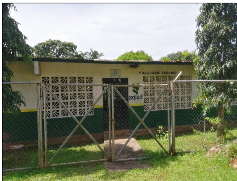
Figura 70. Puesto de Salud de Tebario
