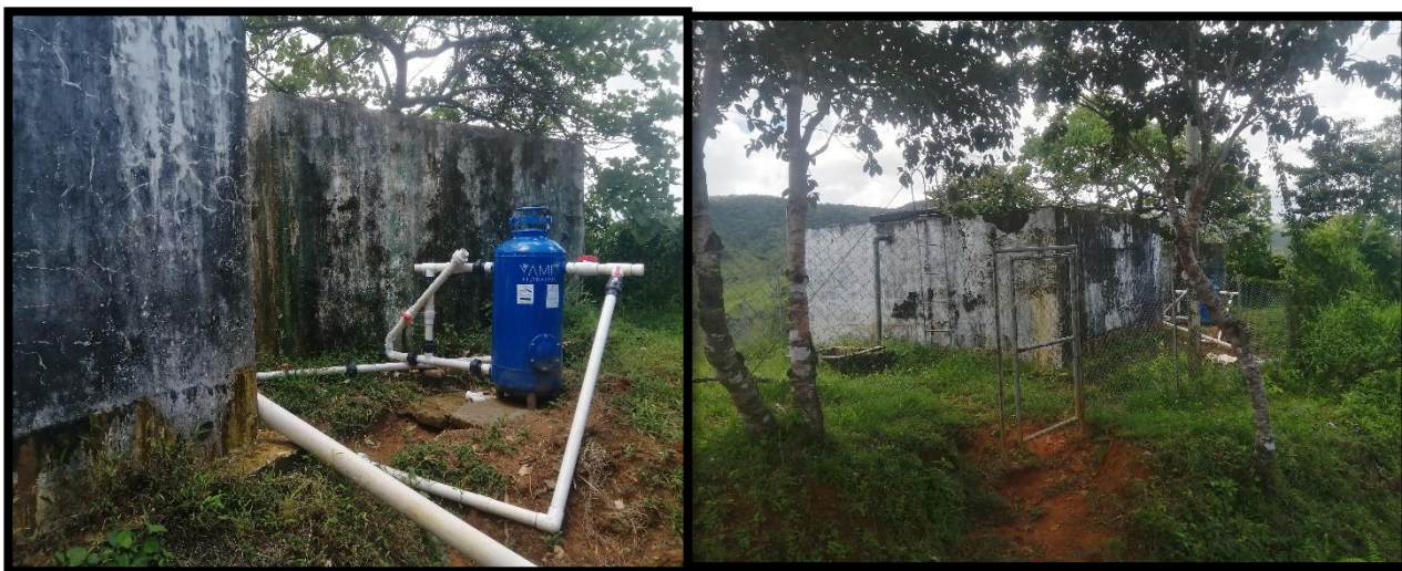
Tanque de almacenamiento del acueducto del Toro
