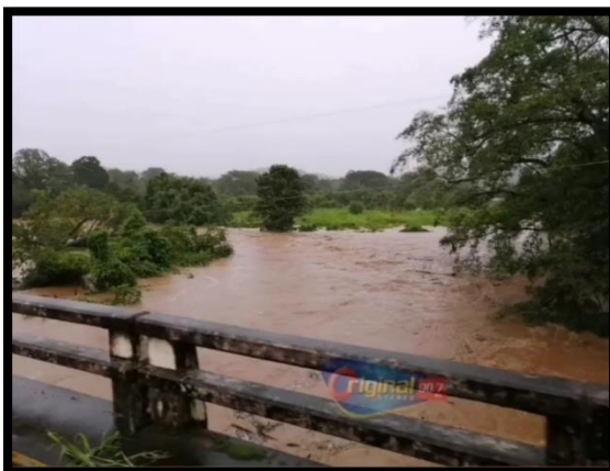
Figura 16. Puente del Río Suay.
