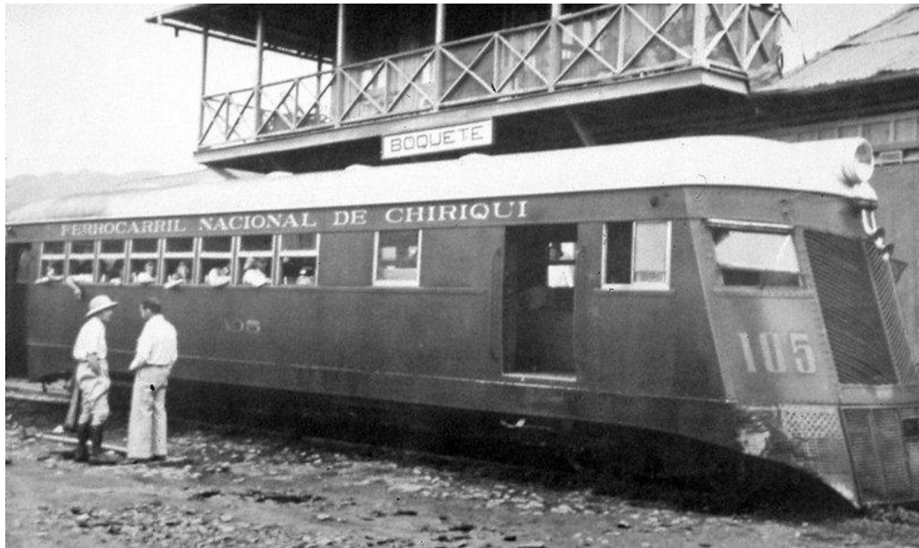
Fotografía del Ferrocarril de Chiriquí, en su estación de Boquete.
