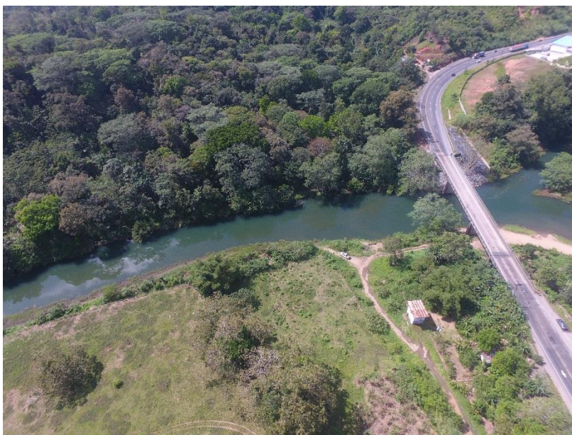
Figura. 20 Vía Transísmica, sobre el río Gatún
