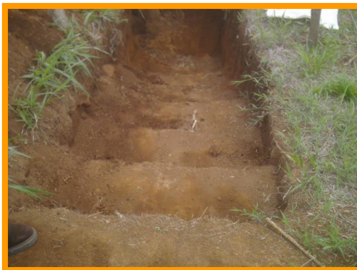
ANEXO 20. Calicatas ya terminadas donde se observan los diferentes estratos del suelo en estudio.
