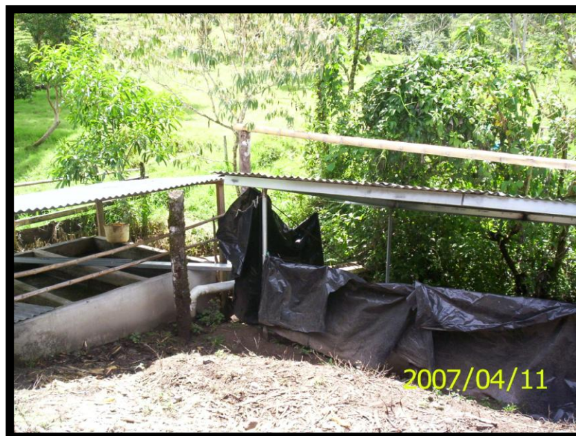
Figura N° 6 Tinas de Separación de Sólidos combinado con Biodigestor
