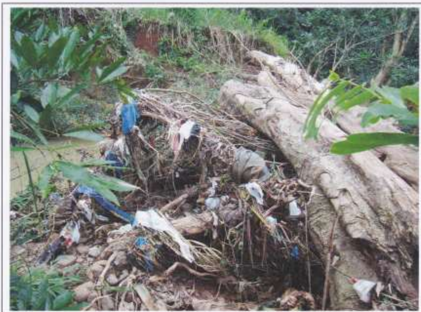
Obstrucción del Cause en Río Burunga
