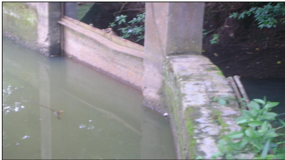
FÍGURA 8: Vertedero Tipo Compuerta con Secciones Rectangulares Ubicada Sobre la Quebrada La Berrona
