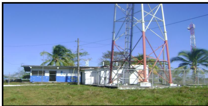
FÍGURA 5: CASETA DE BOMBEO DE AGUA DEL IDAAN QUE SE UBICA EN EL BRAZO DEL RÍO CHIRIQUÍ
