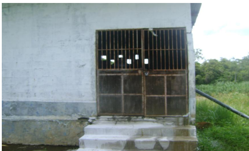
FÍGURA 4 PLANTA POTABILIZADORA DEL IDAAN UBICADA EN EL CERRO LAS MUJERES EN EL CORREGIMIENTO DE CHIRIQUÍ
