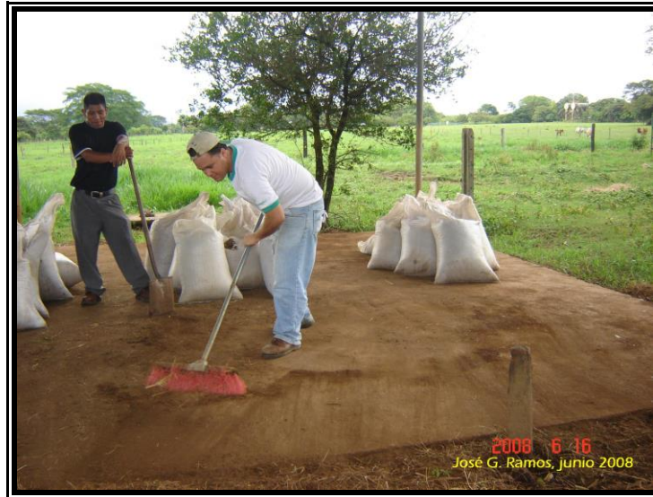
. ANEXO No. 1. Limpieza del área de trabajo para establecer el ensayo
