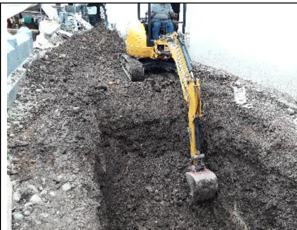
Figura N° 71. Vista del Cuadrante.
