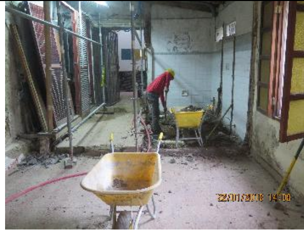
Figura N° 4. Levantado de pisos.
