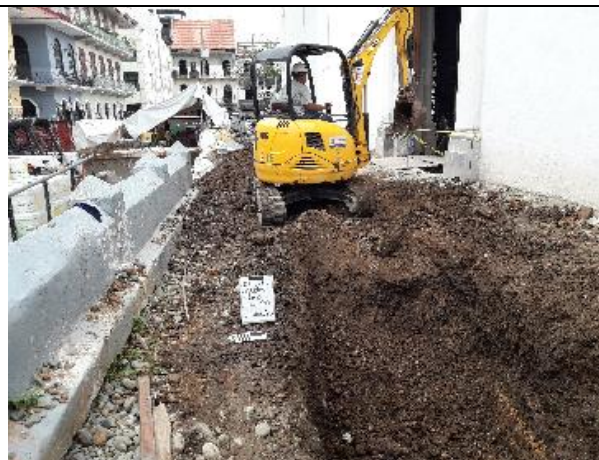
Figura N° 72. Vista general de avance.
