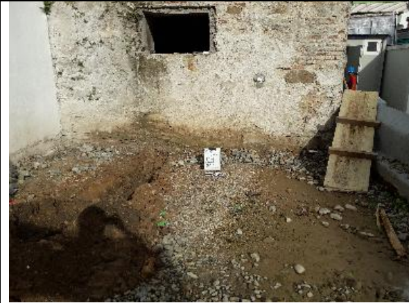
Figura N° 67. Vista del Cuadrante A-4.
