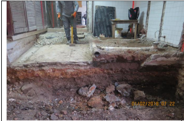
Figura N° 19. Vista general de perfiles
