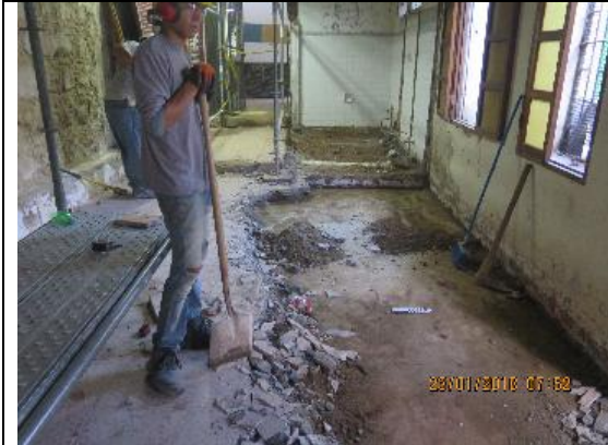
Figura N° 5. Levantado de pisos.
