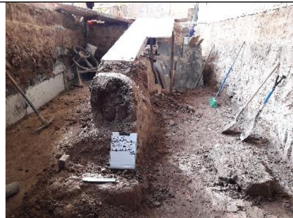
Figura N° 65. Vista del Cuadrante A-2.
