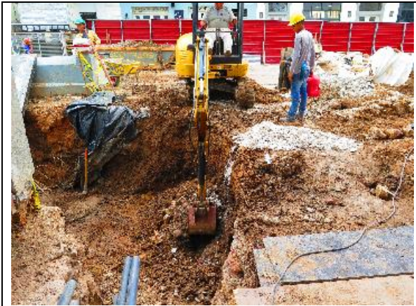
Figura N° 73. Monitoreo de trincheras.
