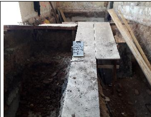
Figura N° 59. Vista del Cuadrante A-3.
