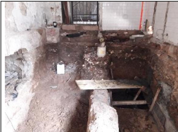
Figura N° 63. Vista del Cuadrante A-2.
