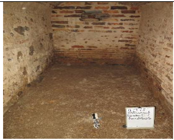
Figura N° 78. Vista de cripta despejada.
