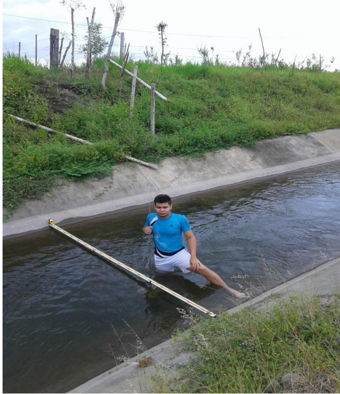
Realización de Aforo en el Canal de Conducción Principal
