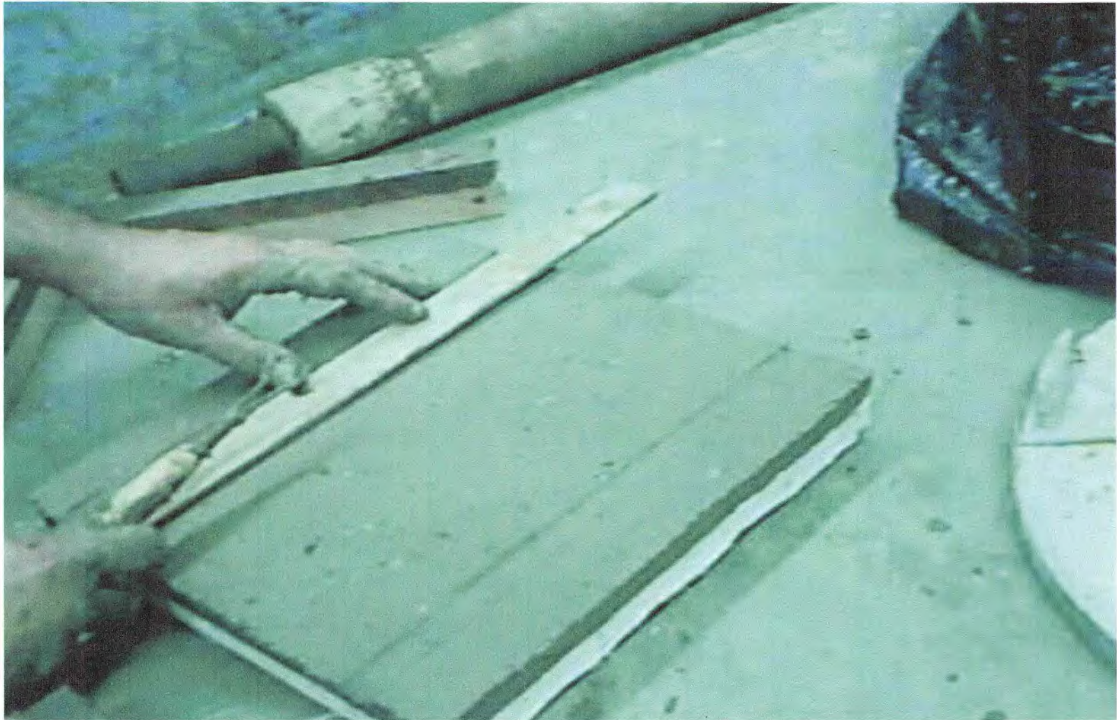
Figura N° 107. Una vez llenado el molde con arcilla y eliminado su saturación con la regleta, se procede a pasarle con el rodillo en la superficie con mucha presión, hasta quedar bien plana la parte superior de la placa. Esto permite eliminar cualquiera burbuja de aire que se encuentre en el interior.
