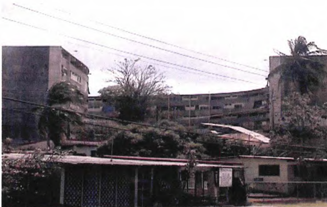
Foto N° 8. Vista de edificios no 3 y no 4 de los abanicos. Fuente: Arq. Carlos Quintero
