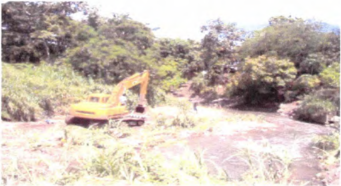
Foto N°2. Dragado del río Matías Hernández. Fuente: Arq. Carlos Quintero
