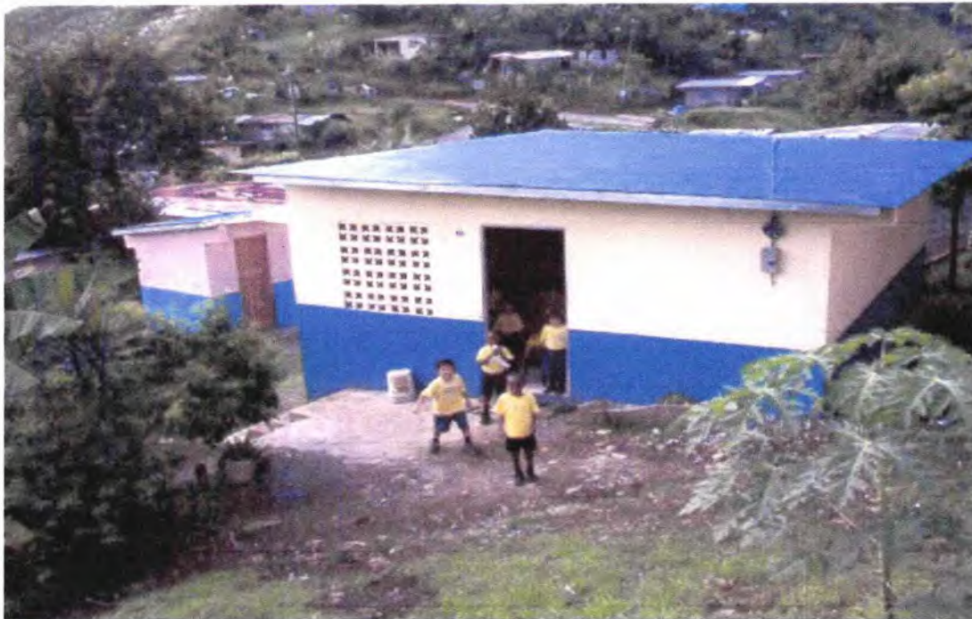
Foto N° 3. Construcción del centro parvulario en la comunidad de altos de la torre. Fuente: Arq. Carlos Quintero.
