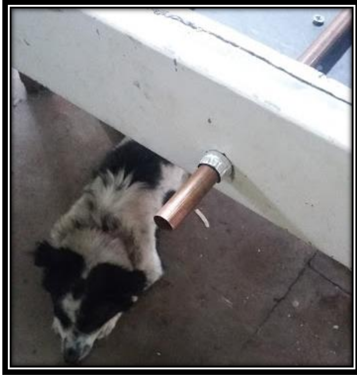
ANEXO Nº 25. Salida de agua del colector
