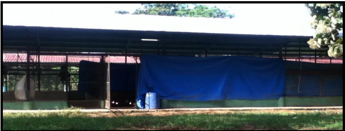
FIGURA 4. INFRAESTRUCTURA UTILIZADAS PARA LA EJECUCIÓN DE LA INVESTIGACIÓN.
