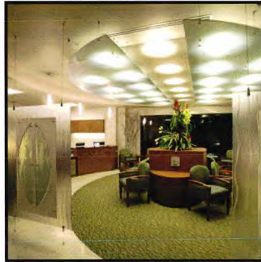
En cielo raso suspendido, y paneles divisorios.
