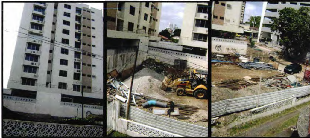
Vistas desde la derecha de la residencia.
