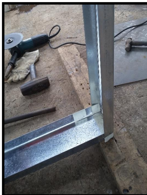
Anexo 9. Doblado de la fascia en las marcas realizadas.
