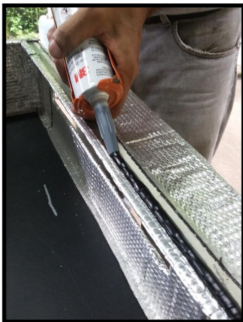
Anexo 34. Cordón de adhesivo de poliuretano sobre el marco.
