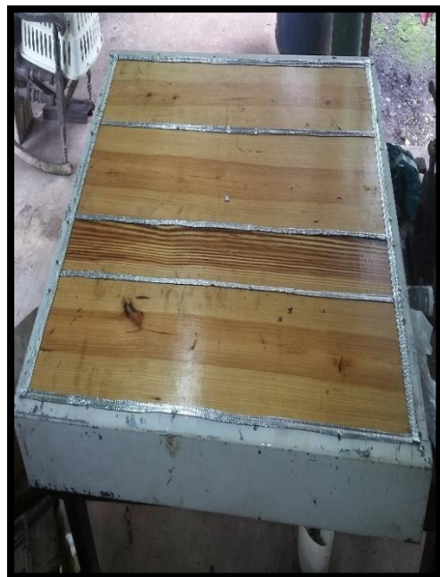
Anexo 21. Adhesión de cinta asfáltica en las aberturas entre las piezas madera.
