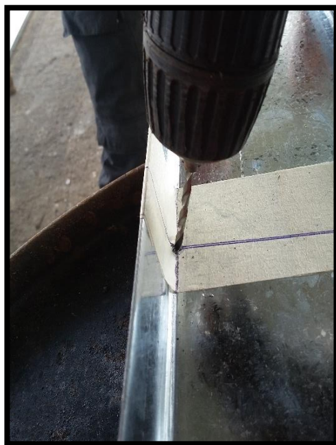
Anexo 4. Taladrado de intersecciones marcadas en área interna de la fascia.
