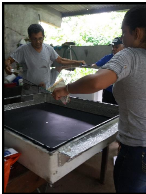
Anexo 35. Instalación del vidrio sobre el marco del colector.
