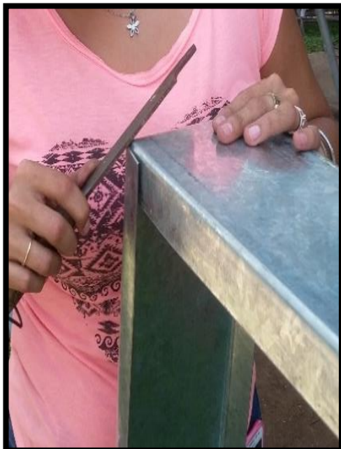
Anexo 10. Desbaste en las esquinas perforadas en la fascia.
