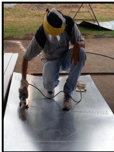
Anexo 23. Corte de las medidas marcadas en la lámina de zinc liso.
