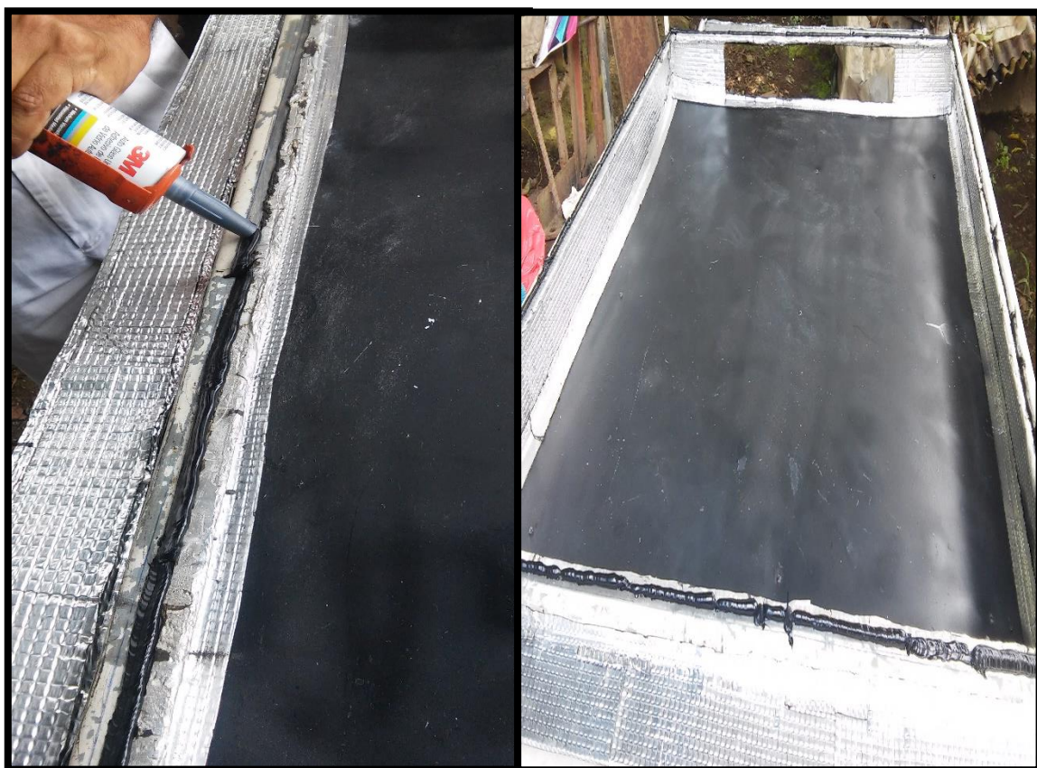
ANEXO 45. Cordón de adhesivo de poliuretano sobre el marco del colector
