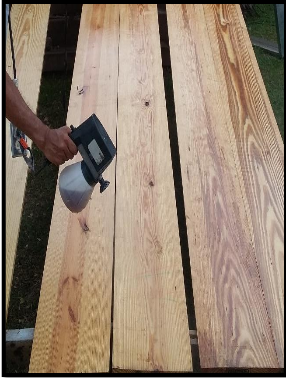
ANEXO 16. Barnizado de la madera
