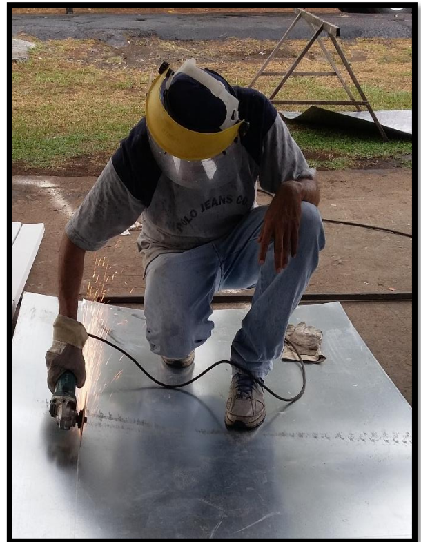
ANEXO 21. Corte de láminas metálicas
