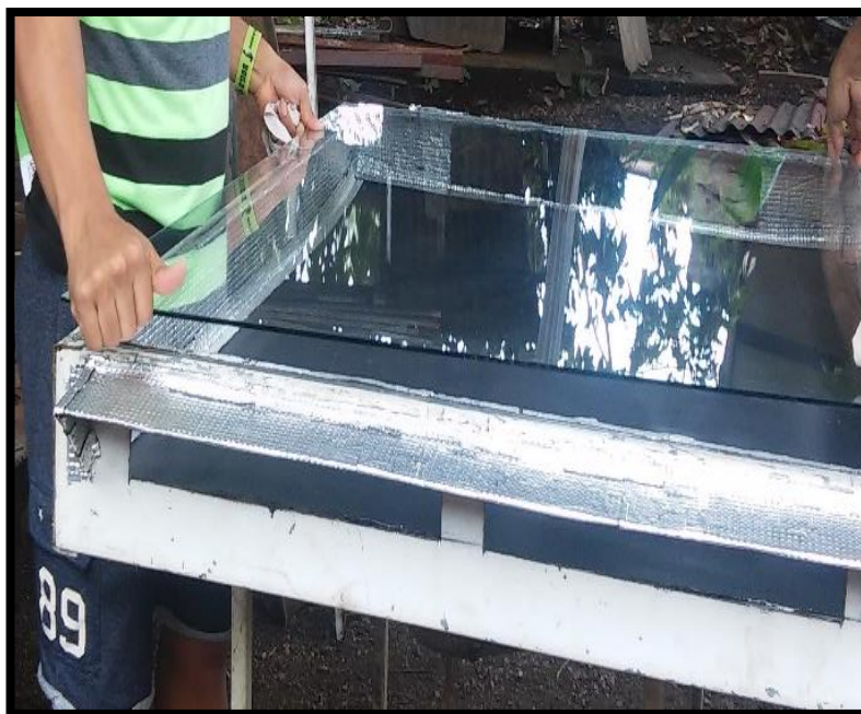
ANEXO 46. Instalación de la cubierta transparente
