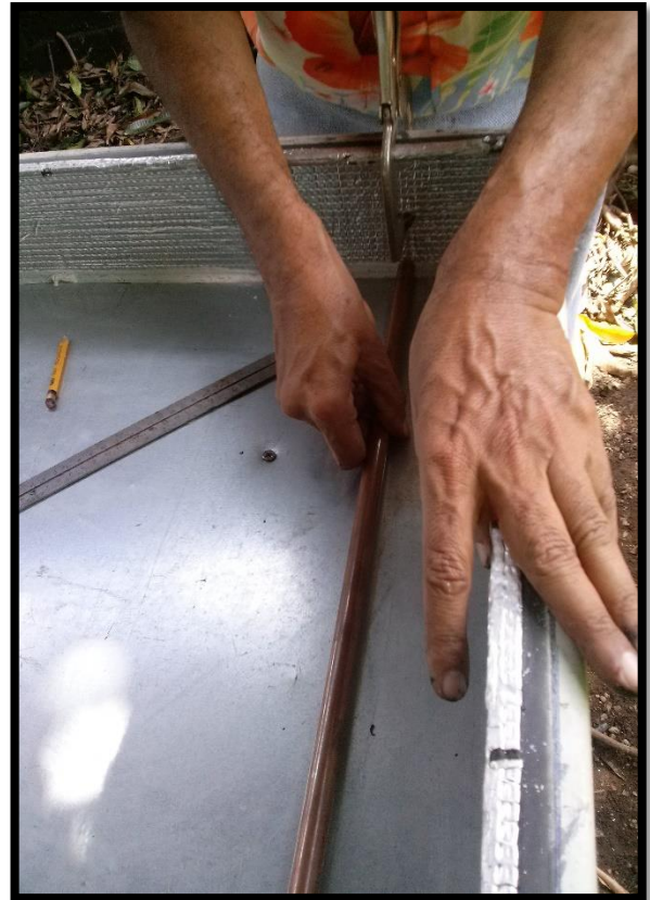
ANEXO 28. Colocación de la tubería dentro del marco del colector
