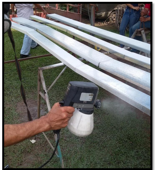
ANEXO 11. Pintado de la fascia
