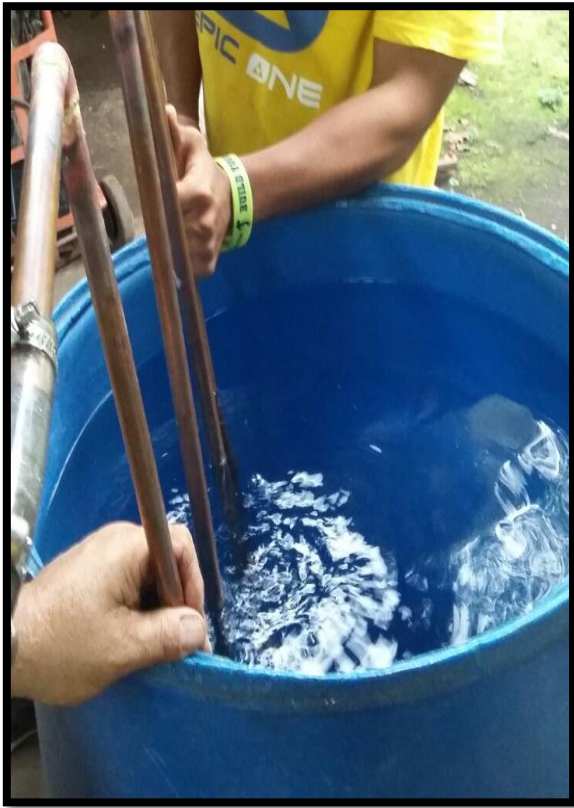
ANEXO 27. Prueba de fugas en la tubería
