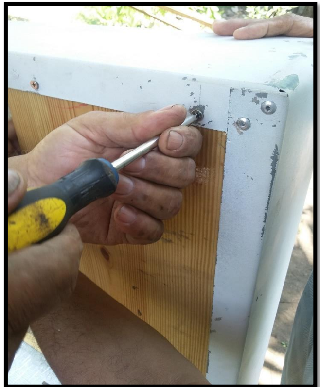
ANEXO 19. Atornillado de la cubierta aislante
