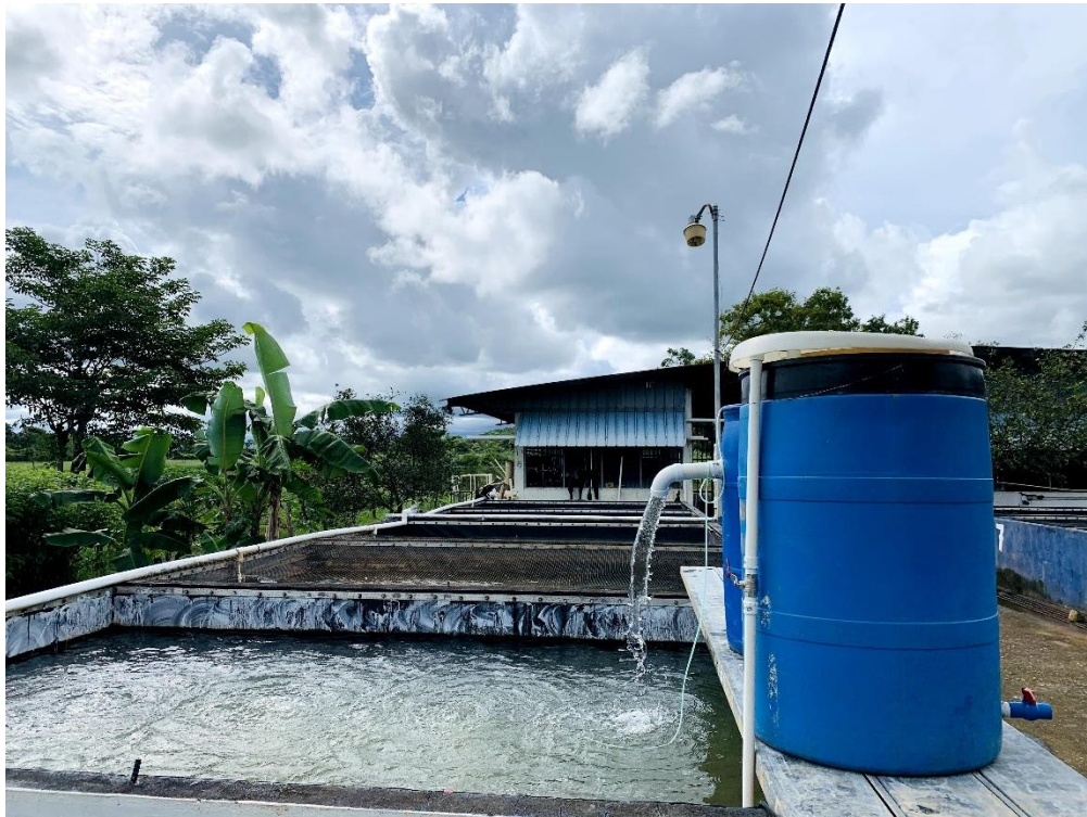
Imagen 3. Sistema de recirculación vista lateral.
