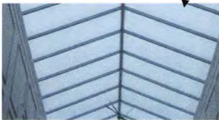
Techo de policarbonato
