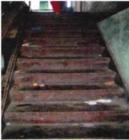
. Tramo de descanso a planta alta
