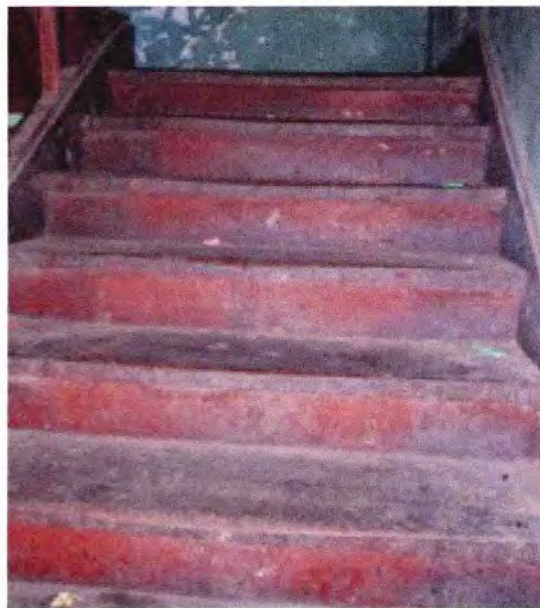
Tramo de planta baja hacia descanso.
