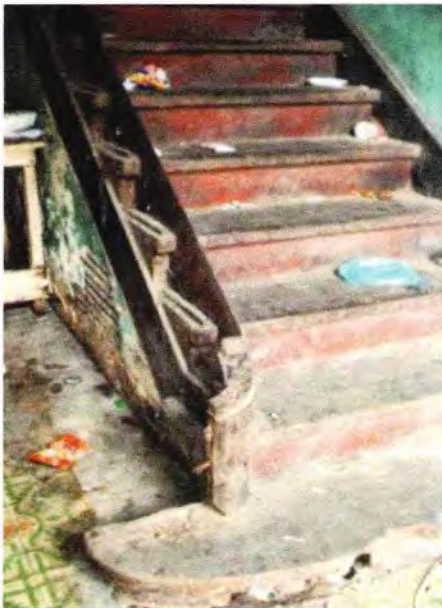
Escalón de arranque
