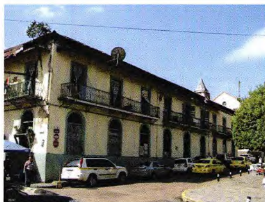
Figura3. Casas de San Francisco , 1877. (Tejeira. E., 2013). Casa con Orden de Valor Patrimonial de II Orden . No restauradas.
