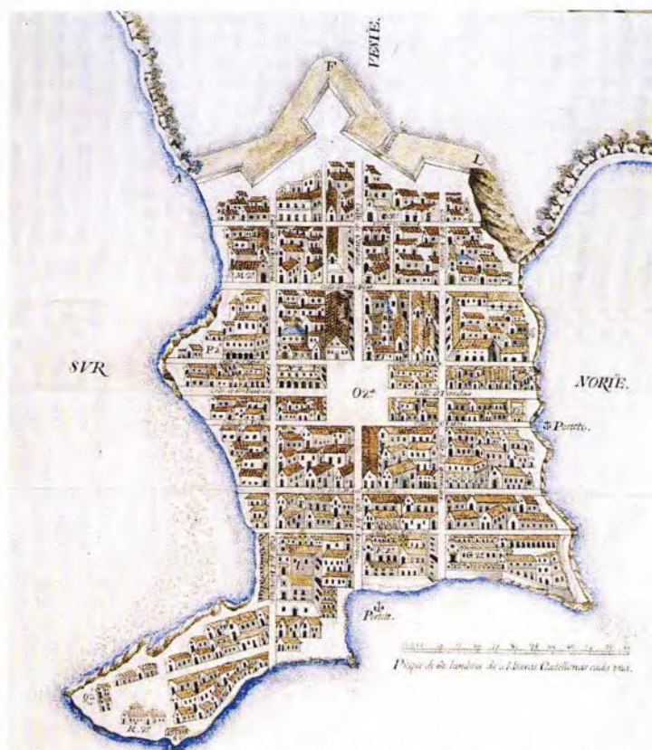
Figura 7. Detalle del “Plano de la Ciudad de Panamá según ha de quedar en el sitio donde se está mudando”, 1673. (Archivo General de Indias, MP-PANAMA,84).
