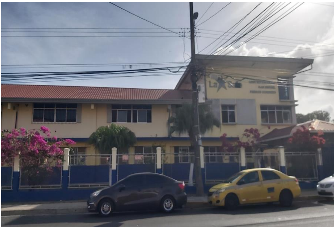
Figura #15 Colegio San Miguel Febres Cordero
