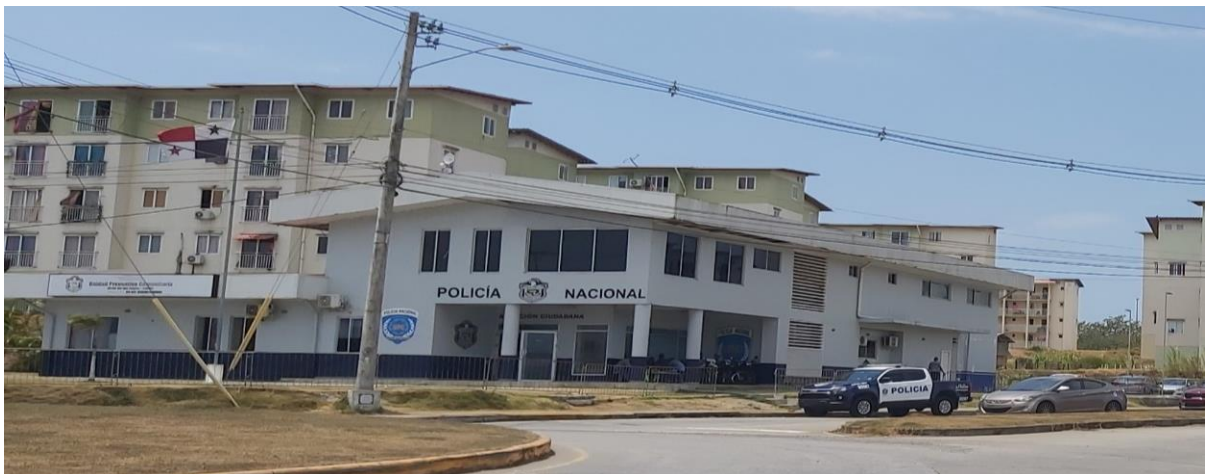
Figura # 18 Estación Policial en Alto de Los Lagos
