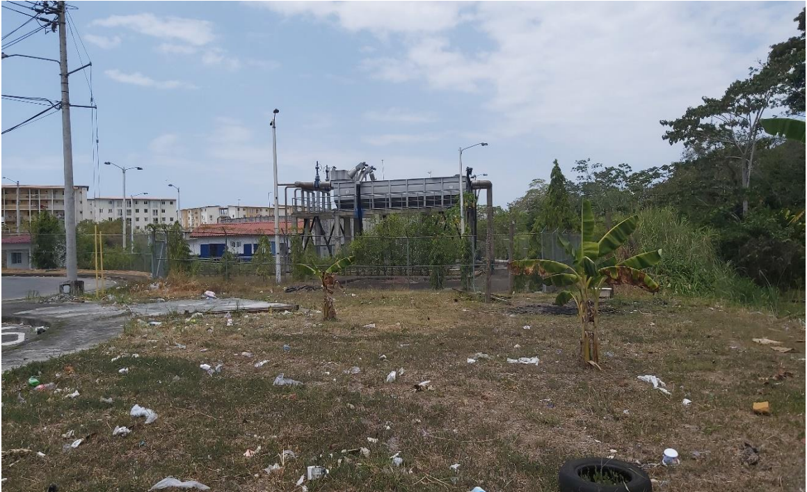
Figura #21 Planta de tratamiento de aguas servidas, proyecto Alto de Los Lagos.
