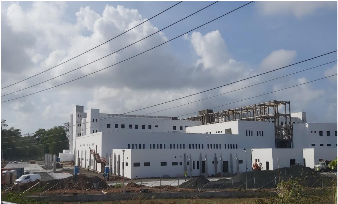
Figura # 19 Construcción del nuevo Hospital Amador Guerrero
